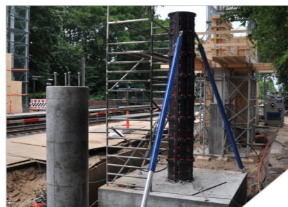
GeoTub Søjleform v/ Kokkedal Station Entreprenør: Aarsleff Rail
