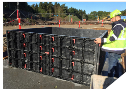
GeoPanel Punktfundament Entreprenør: Ommen og Møller
