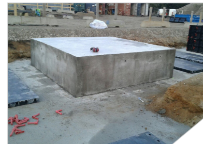
GeoPanel Punktfundament. Entreprenør: Ommen & Møller
