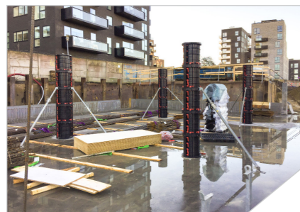
GeoTub Søjleform v/Strandlodsvej Entreprenør: EMR
